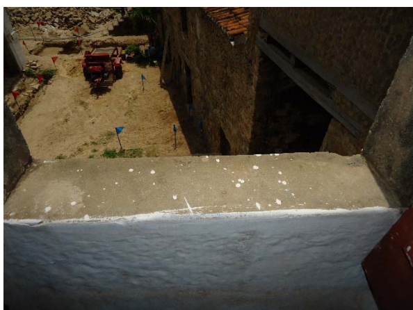
Figura 179 - Marca de tramela na ombreira esquerda e rachadura.
