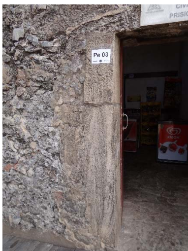
Figura 202 - A ombreira direita foi substituída.
