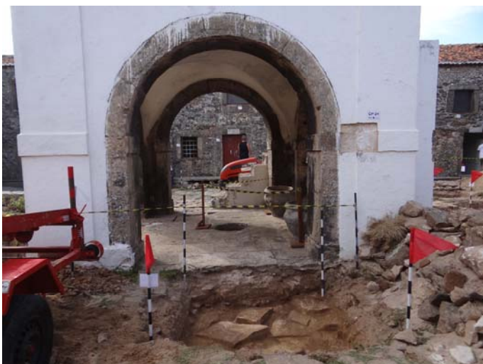
Figura 62 – primeira visualização da estrutura em degrau de acesso à área abaixo da Casa de Pólvora.
