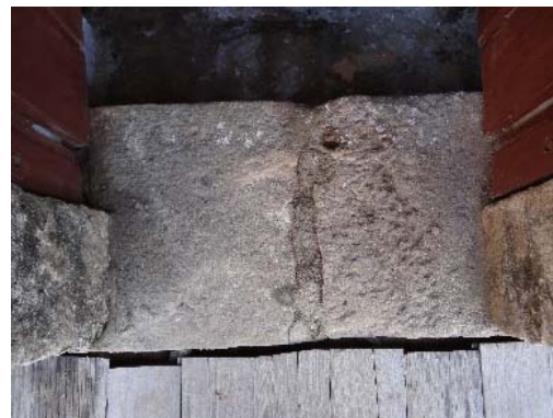
Figura 261 - Soleira composta por duas pedras em cantaria.
