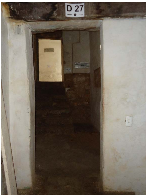
Figura 287 - Panorâmica da Porta entre as dependências 20 e 27.
