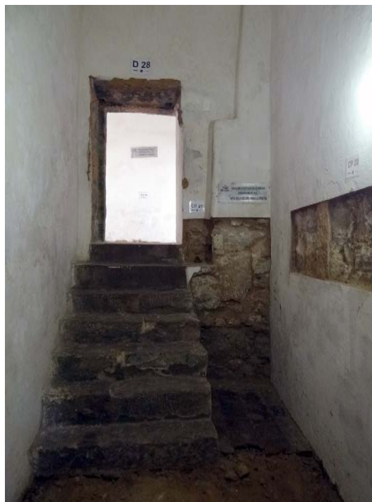
Figura 445 - Atualmente a escada da casamata 2 apresenta sete degraus.
