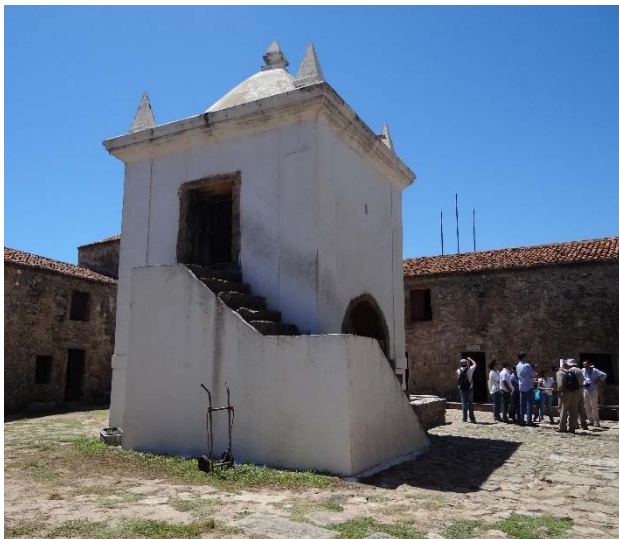
Figura 371 - Acesso à casa de pólvora em dois patamares.
