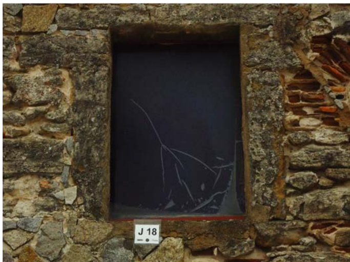
Figura 140 - Panorâmica da Janela 18 fechada com vidro.
