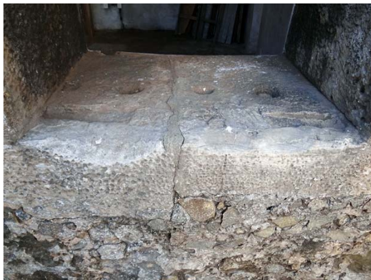
Figura 103 - O desgaste do peitoril indica ter sido usado como amolador.
