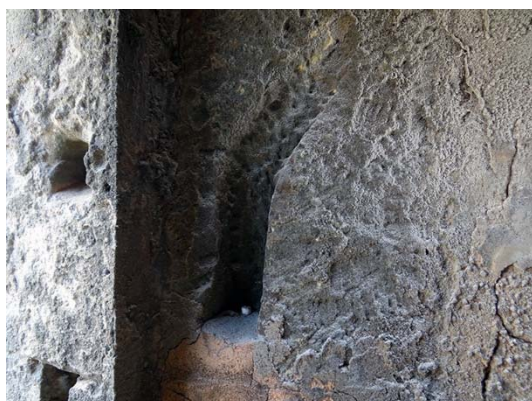
Figura 107 - Marca de tramela no vão.
