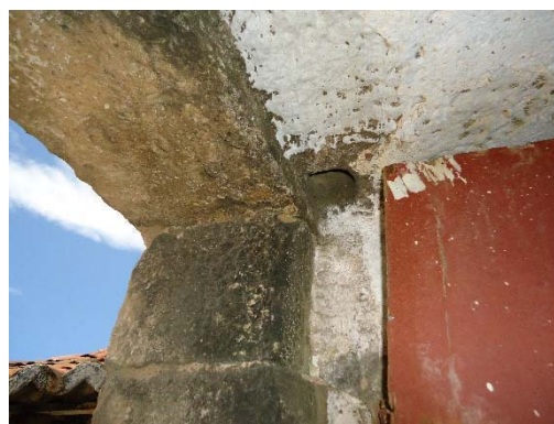
Figura 180 - Marca de eixo na verga.
