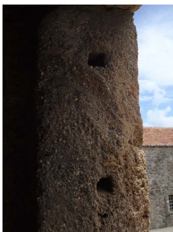
Figura 171 - Marca de grade na ombreira esquerda.
