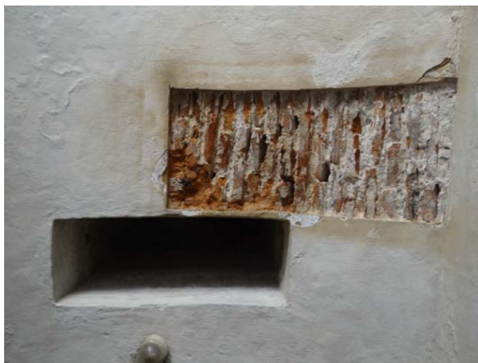
Figura 331 - Traidor sobre o trânsito.
