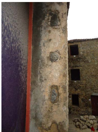
Figura 155 - Marca de grade na ombreira esquerda.
