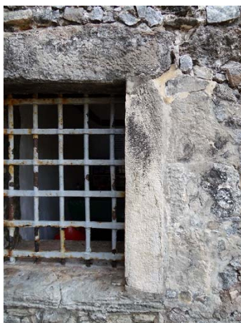
Figura 77 - A ombreira esquerda foi substituída.
