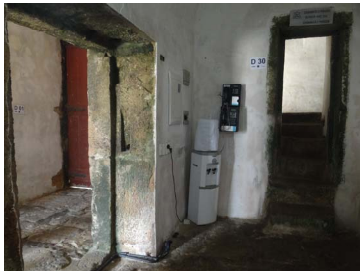
Figura 360 - À esquerda porta de acesso entre-se no segundo vão do trânsito. Observe-se a marca de encaixe de tramela que reforçava a porta.
