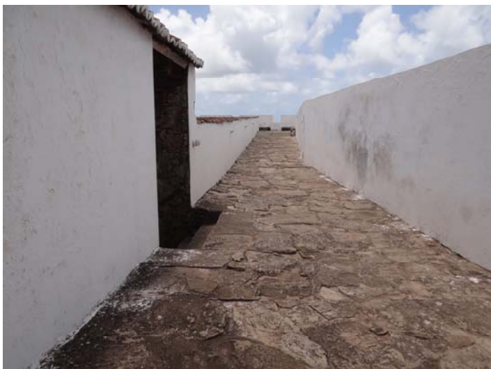
Figura 487 - Escada de acesso ao terrapleno na face leste. Entre as duas escadas existe uma diferença de quatro degraus, o que se reflete no avanço sobre o terrapleno
