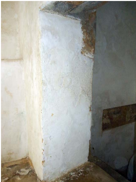
Figura 451 - Ombreira direita reconstruída.
