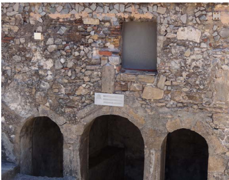
Figura 373 - Conjunto de porta e janelas da dependência D17, em arco.
