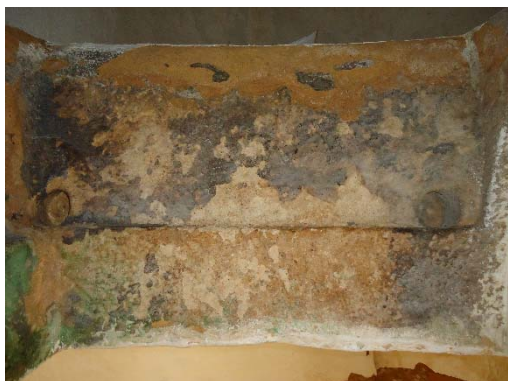
Figura 294 - Verga com marcas de encaixe e desbastada no lado da dependência D28.
