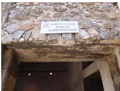
Figura 230 - A verga foi substituída por concreto.
