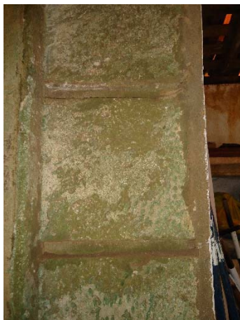
Figura 187 - Marcas de canaleta nas ombreiras, sugerindo uso de prateleiras.
