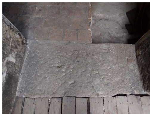
Figura 223 - A soleira foi substituída ou o vão era mais estreito.
