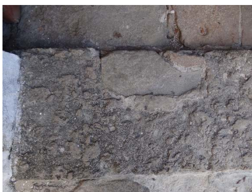
Figura 196 - Conserto da soleira com pedra e argamassa.
