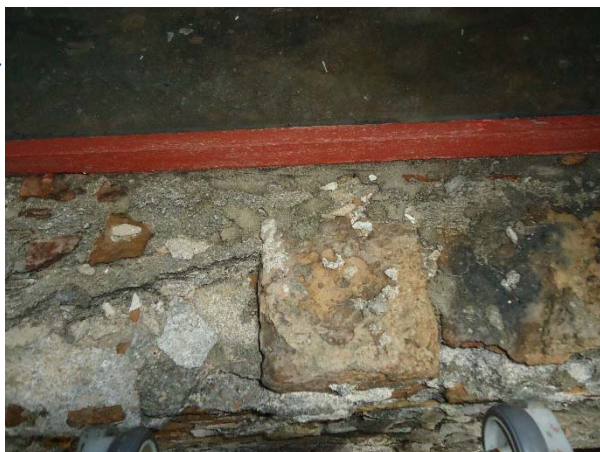
Figura 135 - Peitoril feito em granito e tijolo.
