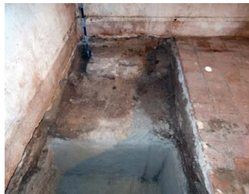
Figura 20 - estrutura na parede P15c.
