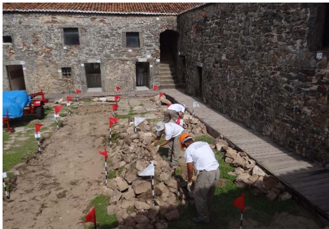
Figura 454 - Linhas perpendiculares à parede W e remoção do piso atual.
