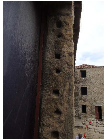
Figura 152 - Marca de grade na ombreira esquerda.
