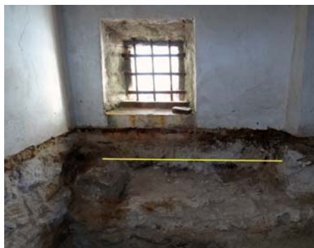
Figura 443 –Nível do piso primitivo.
