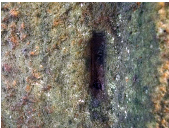
Figura 429 - Detalhe da marca de encaixe do ferrolho na pedra.
