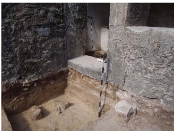
Figura 70 - A escada de acesso à cisterna está na mesma cota do piso atual.
