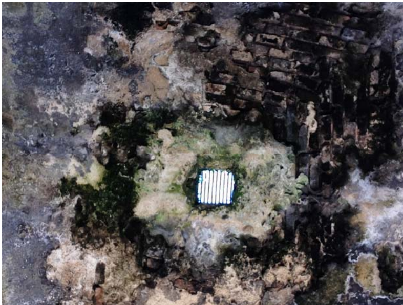
Figura 335 - Detalhe da mesma estrutura, vista a partir do trânsito.
