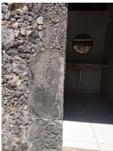
Figura 214 - Parte da ombreira direita foi substituída.
