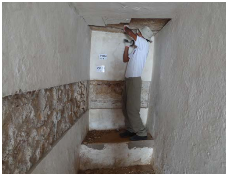
Figura 424 -Execução do corte CP 32.
