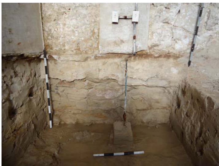
Figura 25 - Alicerce em sossa até próximo a linha da cota inferior do reboco - CH 87.
