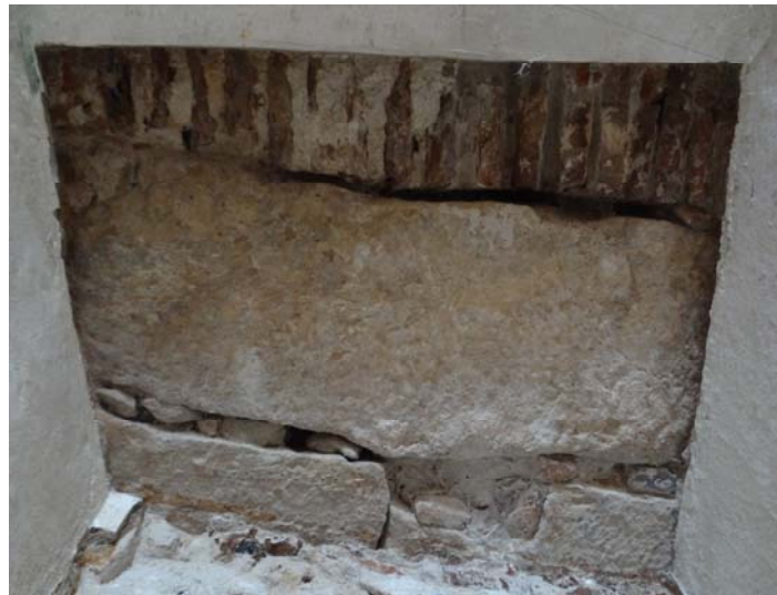
Figura 423 - Próximo à segunda porta, o arco em tijolo dá lugar a lajes de pedra.
