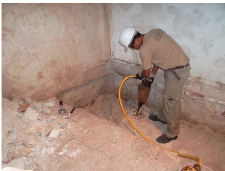
Figura 412 - Uso do martetele hidráulico para rebaixar a estrutura.
