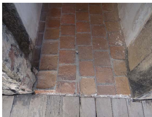
Figura 211 - A soleira está coberta por tijoleira quadrada.
