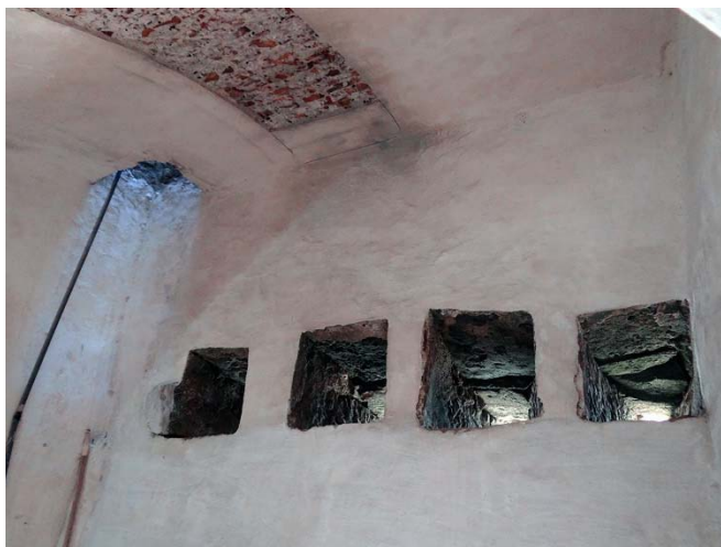
Figura 435 - Estruturas de ventilação da 1ª casamata: quatro elementos vazados e chaminé.
