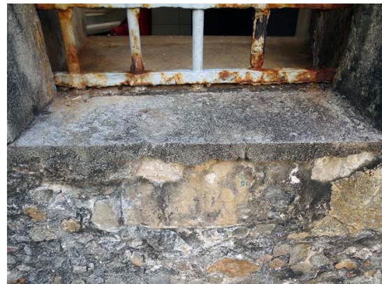
Figura 91 - O peitoril foi reconstruído.
