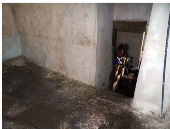
Figura 438 - O piso desce dentro no sentido da canhoneira poderia levar as águas a escoarem também pela porta.
