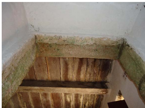
Figura 291 - Verga sem marcas de encaixe.
