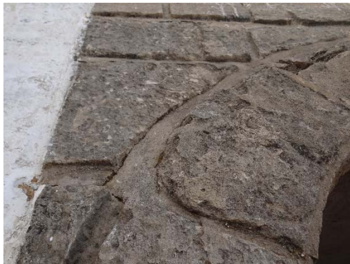
Figura 194 - Conserto em cimento.
