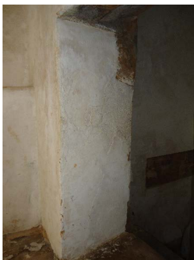
Figura 296 - Um a das ombreiras está parcialmente rebocada.
