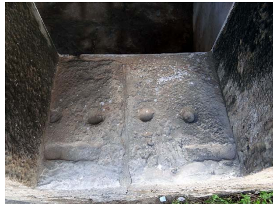
Figura 102 – O peitoril apresenta marcas de grade e canaleta.
