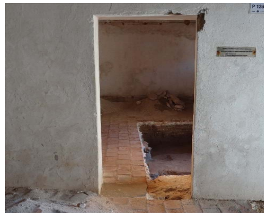
Figura 284 - O vão da porta entre os cômodos 12 e 13 está rebocado.
