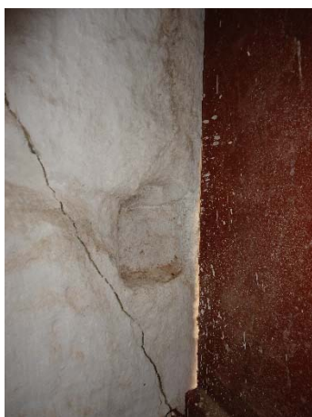
Figura 179 - Marca de tramela na ombreira esquerda e rachadura.
