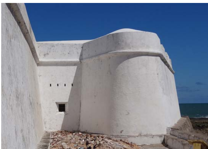
Figura 449 - Face externa da casamata 2 apresentando as aberturas para ventilação.
