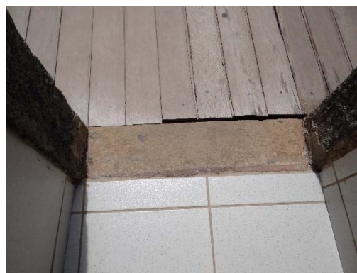
Figura 215 - A soleira foi substituída.
