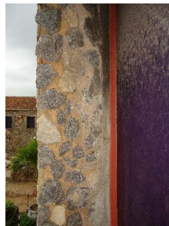
Figura 156 - A ombreira direita está coberta por granito.
