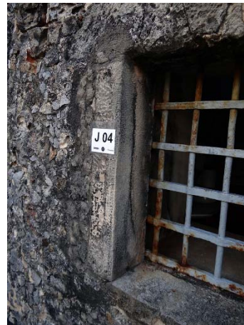
Figura 89 - A ombreira direita foi substituída.
