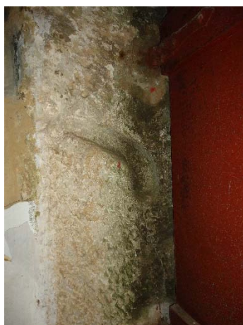
Figura 163 - Marca de tramela na ombreira esquerda e rachadura acentuada.
