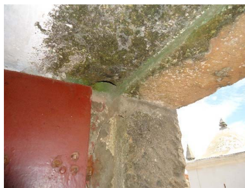
Figura 168 - Marca de eixo na verga
