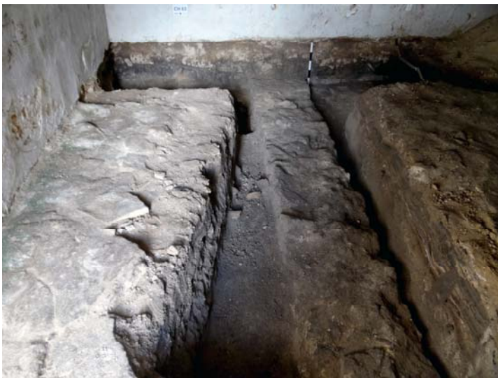
Figura 32 - Alicerce da parede que, paralela à contra muralha, forma as dependências da face sul do Forte dos Reis Magos.
