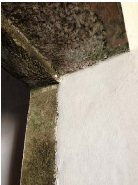
Figura 366 - Observe-se que deste outro lado da verga não há marca quer de pivô, quer de chumbamento de dobradiça.
