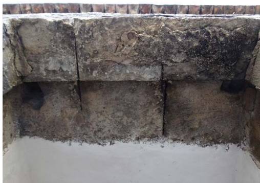
Figura 210 - Pedra de centro e marcas de eixos na verga.
