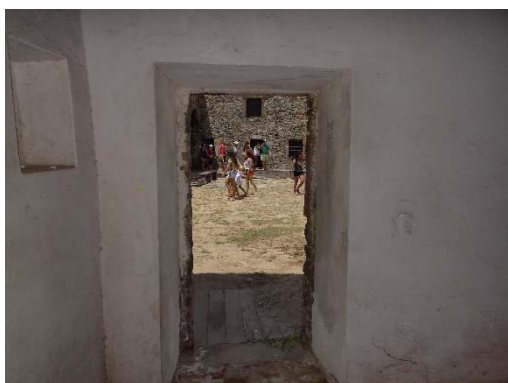
Figura 251 - O vão rebocado não permite a observação de marcas de uso.
