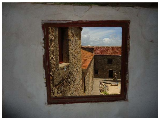
Figura 177 - Vista da janela pelo lado interno
