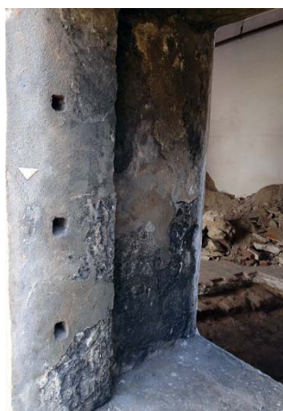
Figura 111 - Nas ombreiras há marcas de grade reconstituídas em cimento.
