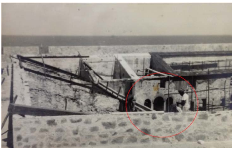
Figura 409 - No documentário das obras em 1972, a janela atingida pela escada encontrava-se aberta. Fonte: Biblioteca do IPHAN, 1125/72.
