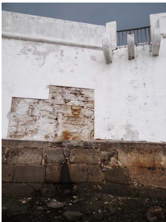
Figura 420 - Corte realizado na muralha leste.
