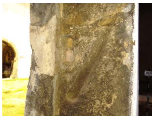
Figura 246 – Marca de ferrolho e tramela na ombreira direita.
