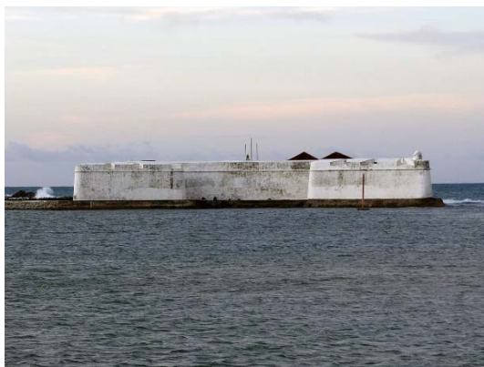
Figura 470 - Foto da face sul na preamar.
