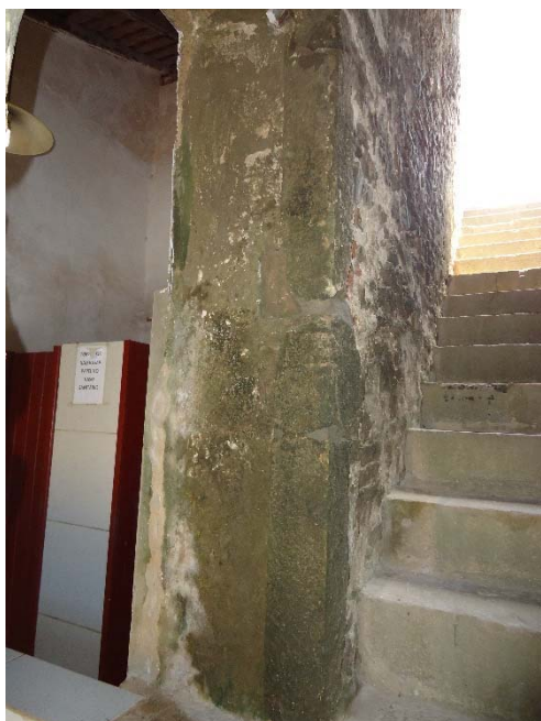
Figura 298 – A porta PI 110-111 fica na lateral da escada oeste e dá acesso aos sobrados.
