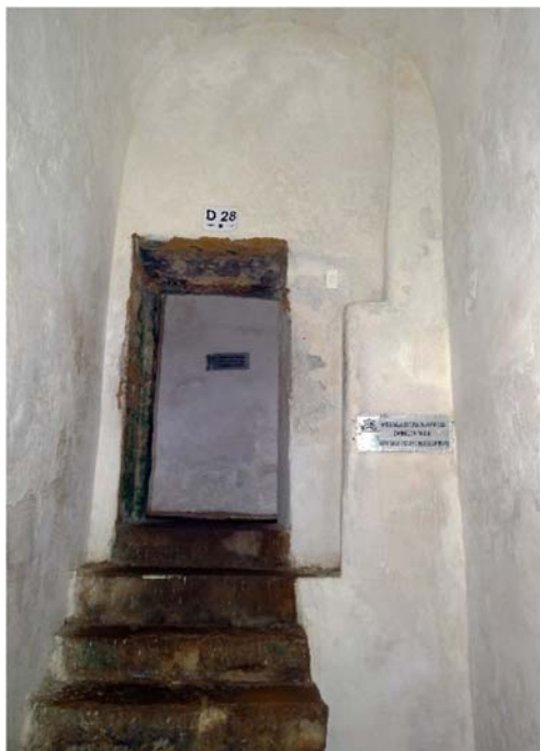
Figura 293 - Panorâmica da Porta e escada entre a dependência D27 e a dependência D28 (casamata leste).
