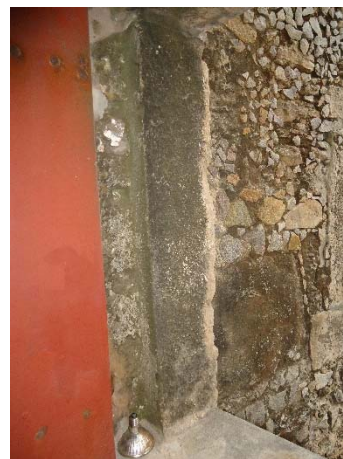
Figura 160 - Ombreira esquerda em arenito.
