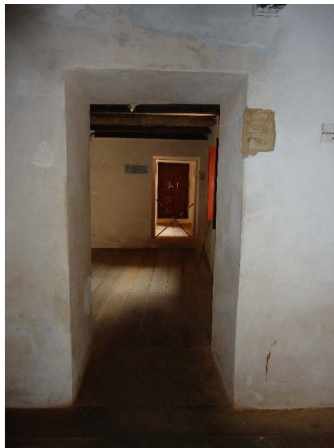
Figura 307 - Panorâmica da porta entre os cômodos 120 e 121, acima de onde hoje estão os banheiros
