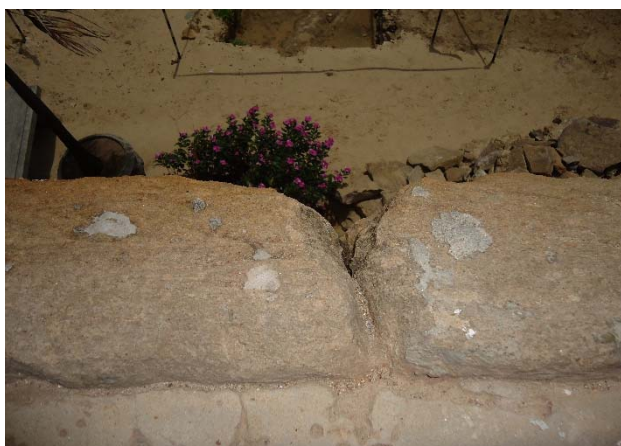
Figura 169 - Peitoril em arenito com desgaste no centro.
