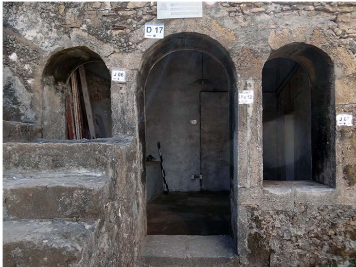
Figura 100 - Pa norâmica da Janela 07.
