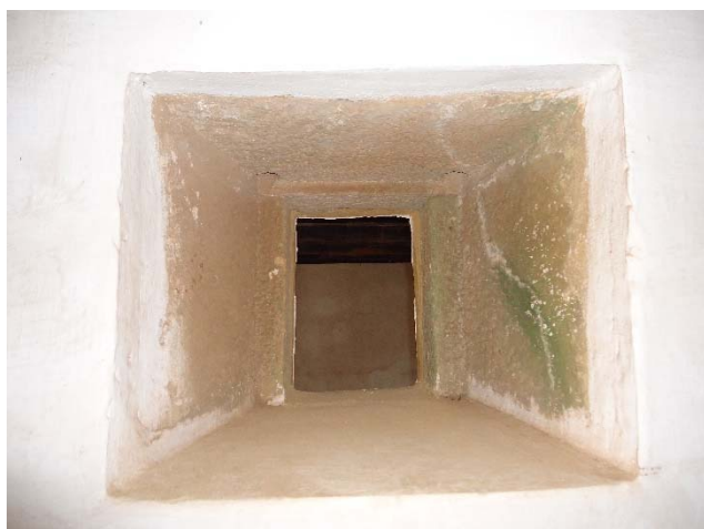
Figura 190 – Janela trapezoidal entre as dependências 120 e 121.
