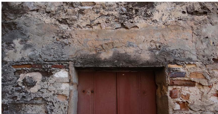
Figura 114 - A verga foi substituída por concreto.
