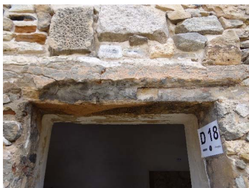
Figura 241 - Verga em concreto
