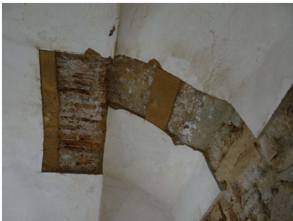
Figura 433 - Na 2ª casamata no fechamento do teto observa-se o uso de cimento portland.
