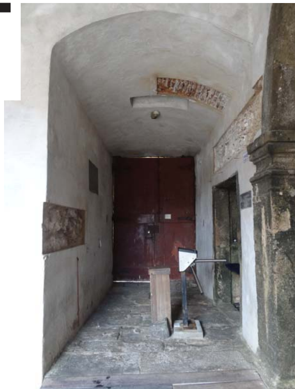
Figura 328 - Vista do corredor do trânsito, tendo ao fundo a porta principal de acesso ao forte.
