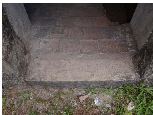
Figura 243 - Soleira substituída.
