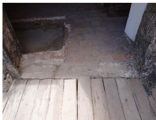
Figura 231 - A soleira foi substituída.
