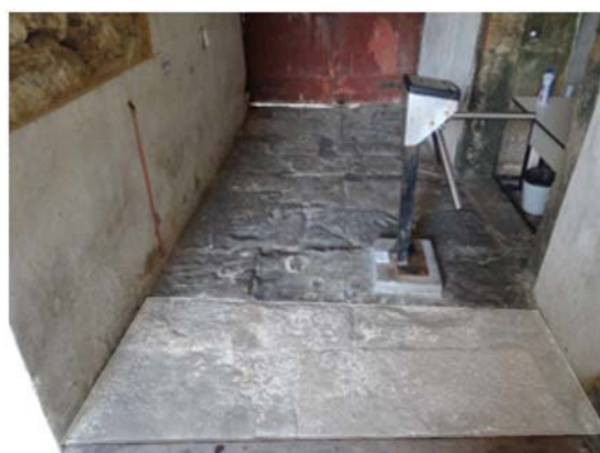
Figura 356 - Ênfase no piso reconstituído de modo a suprimir as marcas da parede.
