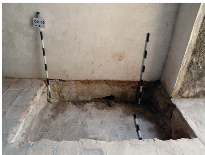
Figura 9 - Estrutura de fragmentos de rocha e argamassa localizada 38 cm abaixo do piso atual.
