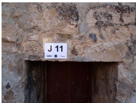
Figura 117 - A verga está reconstruída em granito, arenito e cimento.
