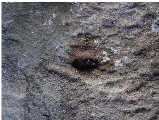
Figura 262 - Marca de eixo na soleira.
