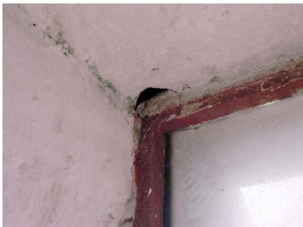
Figura 153 - Marca de eixo obstruída pela grade.
