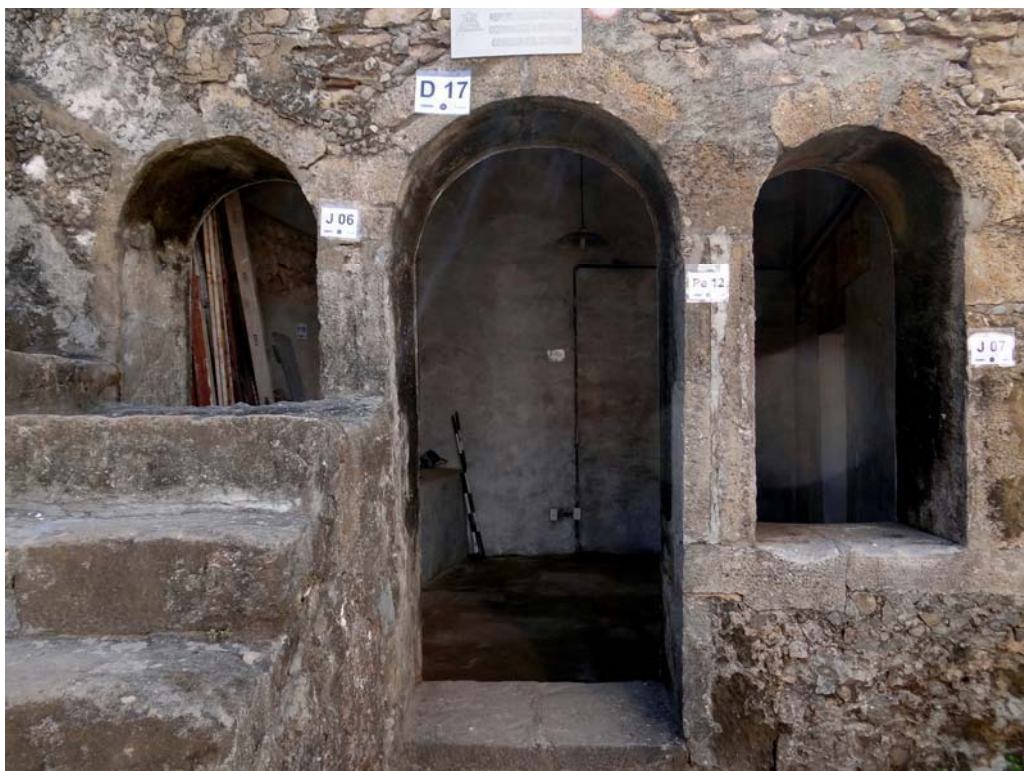
Figura 326 - Arcos em portas e janelas na dependência D17.
