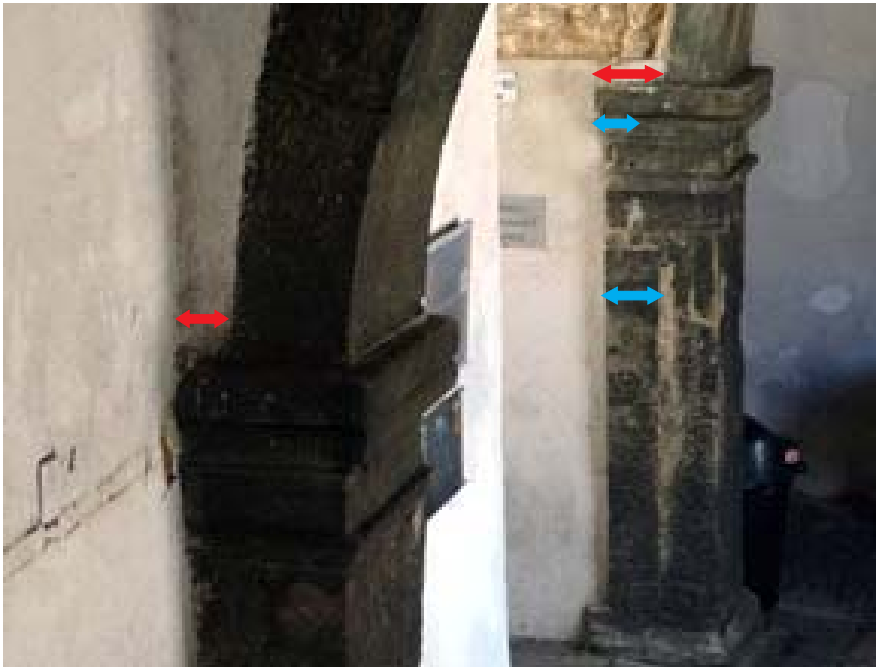
Figura 342 - Observe-se as colunas de suporte de um mesmo arco que apresentam dimensões distintas (setas vermelhas). Observando-se em detalhe, percebe-se que a extensão da largura da coluna (seta azul) se trata de uma prótese, parte em pedra, parte em cimento Portland.
