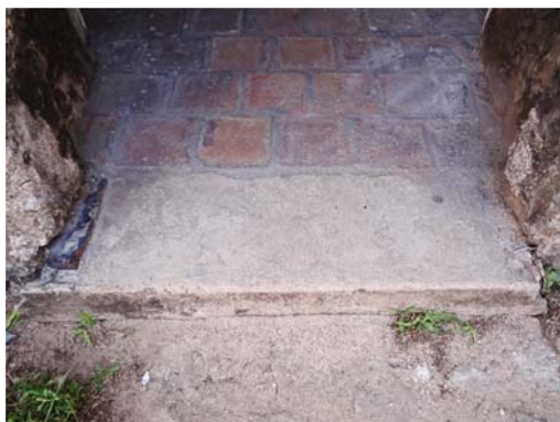
Figura 247 – Soleira substituída.
