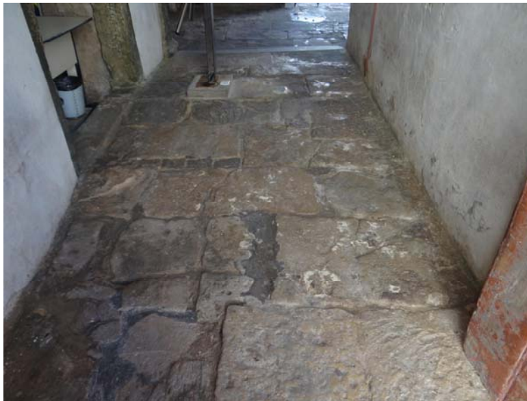
Figura 359 - Extensão do piso do trânsito.
