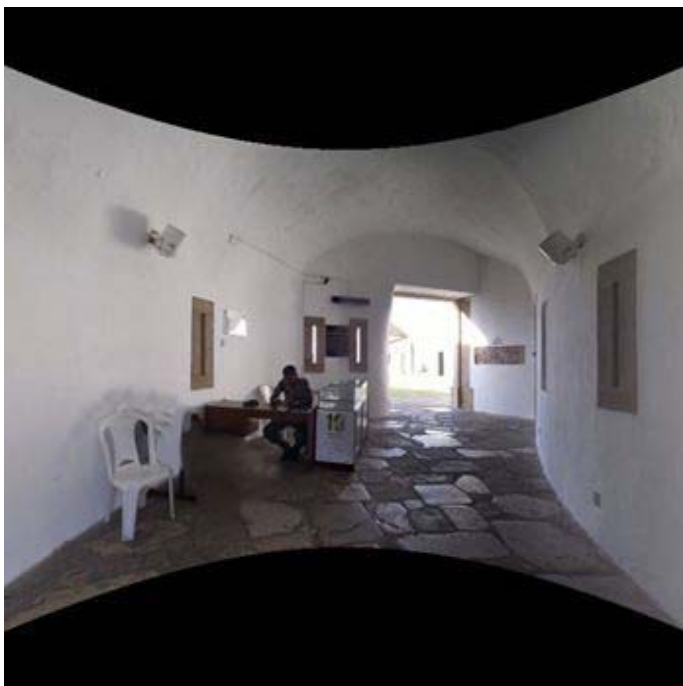
Figura 353 - Interior do trânsito, do forte do Brum, onde se vê, ao fundo, junto à porta, duas seteiras.
