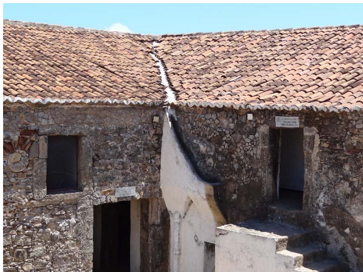
Figura 272 - Panorâmica da Porta 21, de acesso à cisterna.
