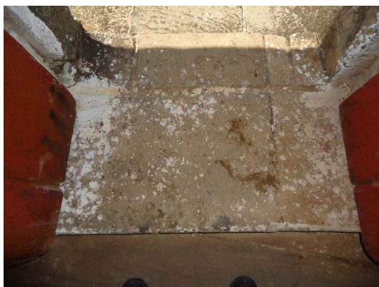
Figura 276 - Soleira de arenito com respingos de tinta.
