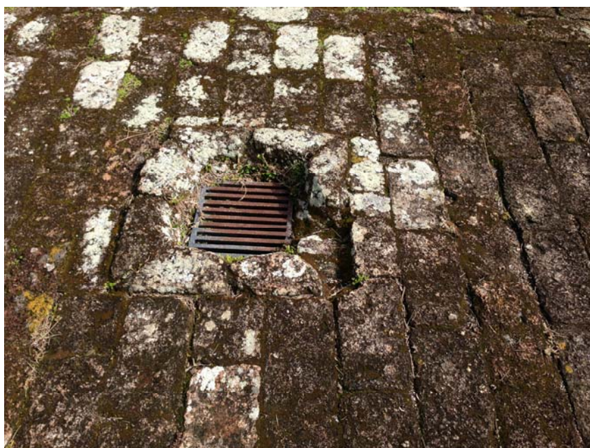
Figura 334 - Detalhe da estrutura vasada, onde hoje foi instalada uma grelha para evitar acidentes com os visitantes.
