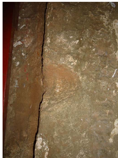
Figura 311 - Marca de amolador na ombreira direita.
