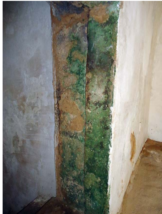
Figura 452 - Marcas de argamassa no centro da ombreira esquerda podem ter disfarçado vestígios de um ferrolho.
