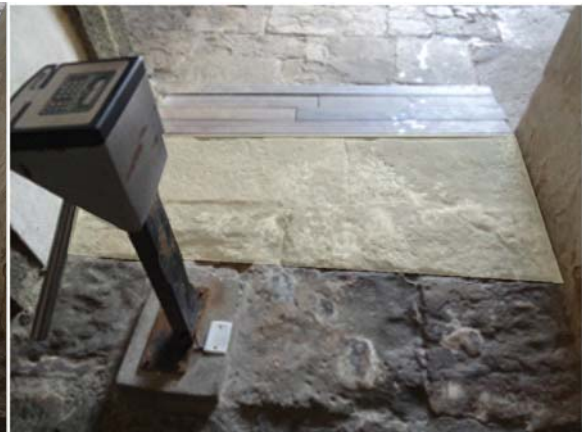
Figura 346 - Realce do piso, no trecho em que cobre a marca de remoção da parede.
