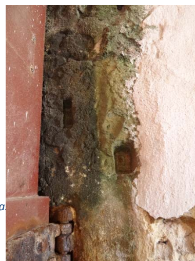
Figura 197 - Duas marcas de ferrolho na ombreira direita.
