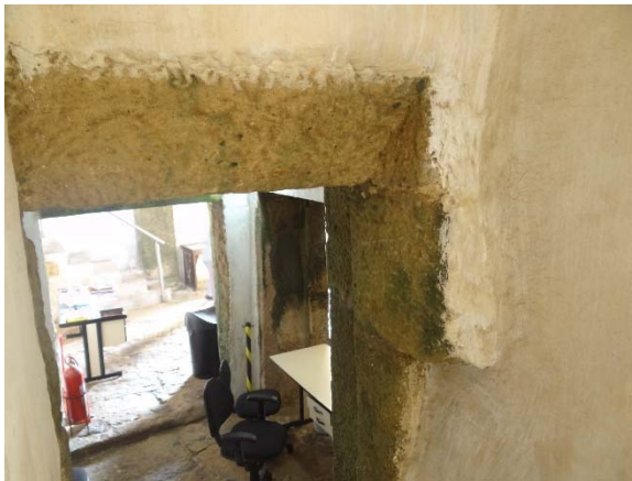
Figura 428 - Verga chanfrada para compensar a pouca altura da porta. Vista a partir do interior da casamata.
