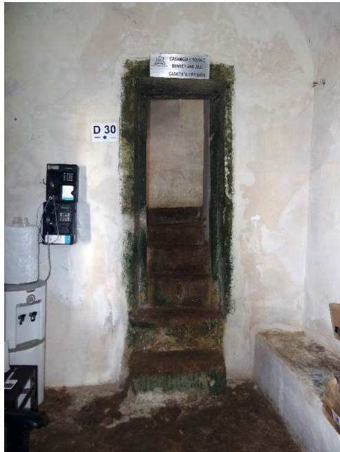
Figura 426 - Vista da escada de acesso à casamata
