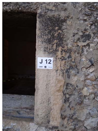
Figura 122 - A ombreira esquerda foi substituída.
