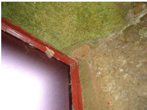
Figura 146 - Marca de eixo fechada com cimento.
