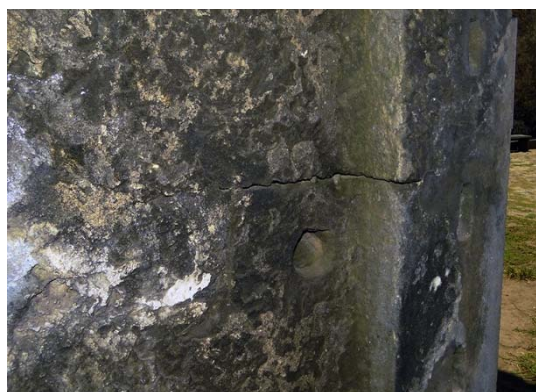
Figura 112 - Marca de ferrolho ou tramela na ombreira esquerda.
