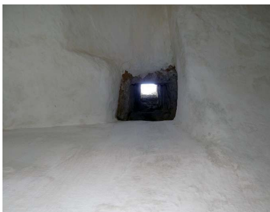
Figura 450 - Chaminé na casamata 2.
