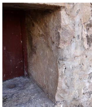
Figura 118 - A ombreira esquerda está parcialmente reconstruído com granito.
