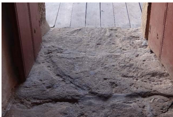
Figura 204 - As duas marcas de porta na soleira são incompatíveis.
