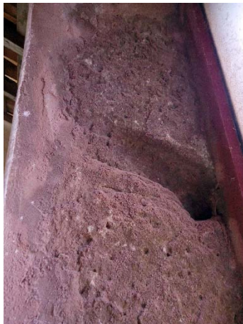
Figura 144 - Marca de tramela na ombreira esquerda. Figura 145 - Marca de tramela na ombreira direita.
