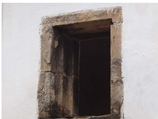
Figura 233 - No vão eram colocadas duas portas...
