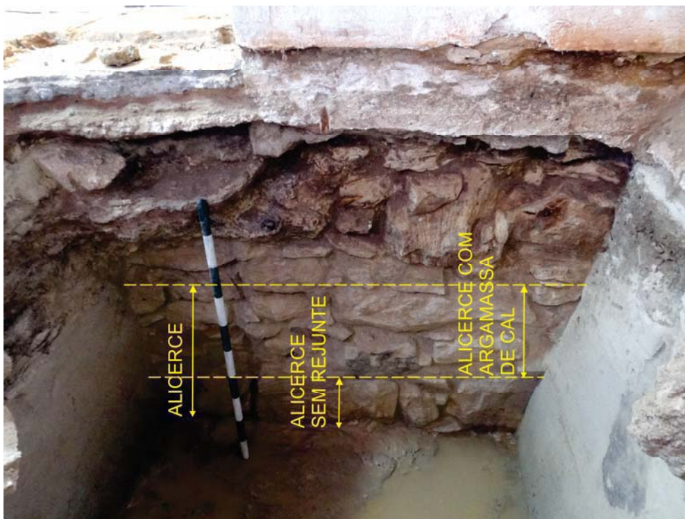
Figura 320 - Detalhe do alicerce da parede D14a.
