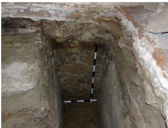
Figura 14 - Alicerce em sossa desde o arrecife até próximo ao primeiro calçamento.
