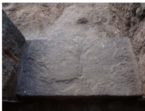
Figura 239 - Soleira parcialmente coberta por cimento.
