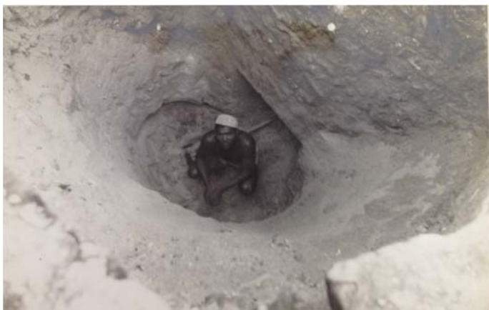
Figura 446 - Foto 1136 do registro fotográfico das reformas promovidas pelo IPHAN em 1972. Seria a vista interna da casamata 2, a partir do baluarte de São Tiago.
