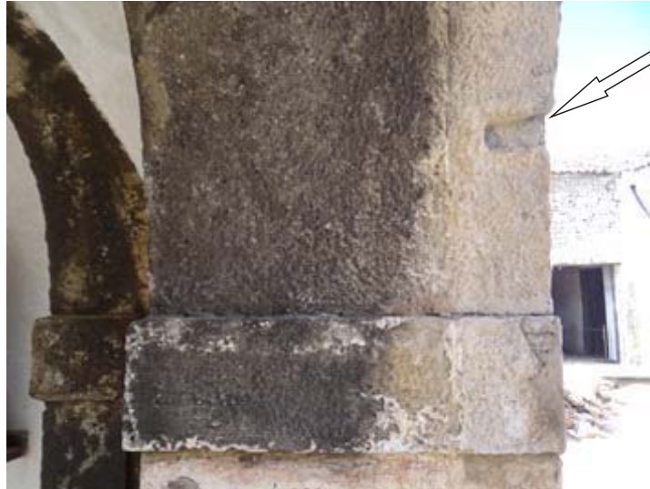
Figura 396 - Marca de encaixe no arco leste.
