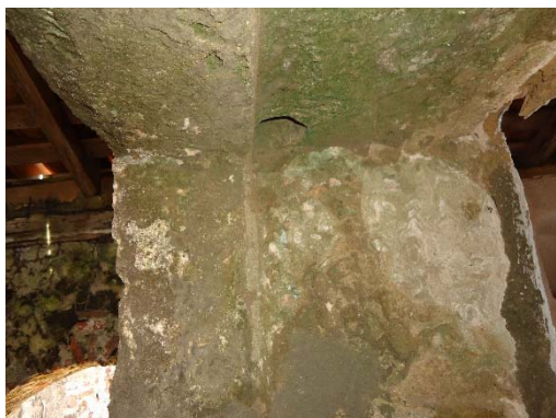
Figura 299 - Verga com marcas de encaixe.
