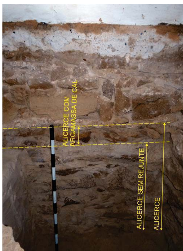
Figura 322 - Detalhe do alicerce da parede D28 b
