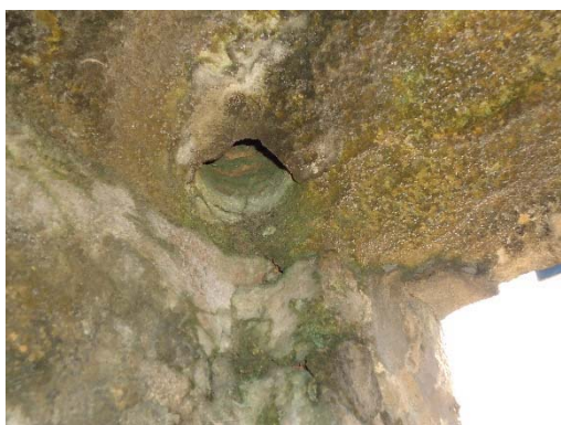
Figura 273 - Marca de eixo na verga de arenito.
