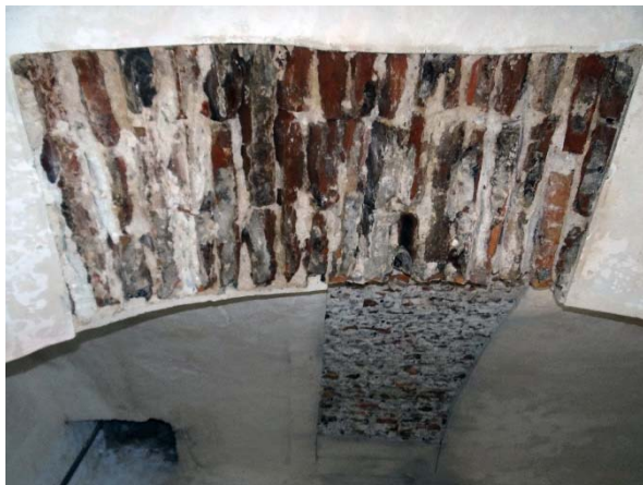
Figura 431 - Em primeiro plano, corte realizado na abóbada da casamata, exibindo a técnica construtiva.
