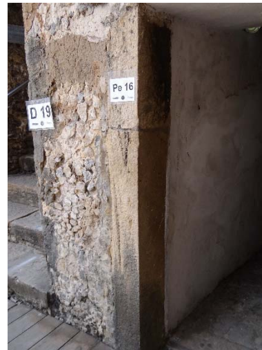
Figura 254 - Ombreira direita substituída.
