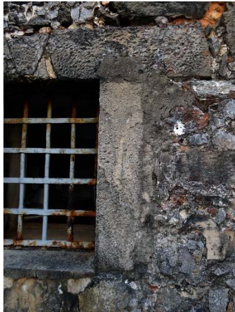
Figura 90 - A ombreira esquerda foi substituída.
