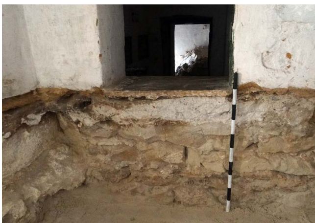
Figura 444 – Degrau em cimento Portland.
