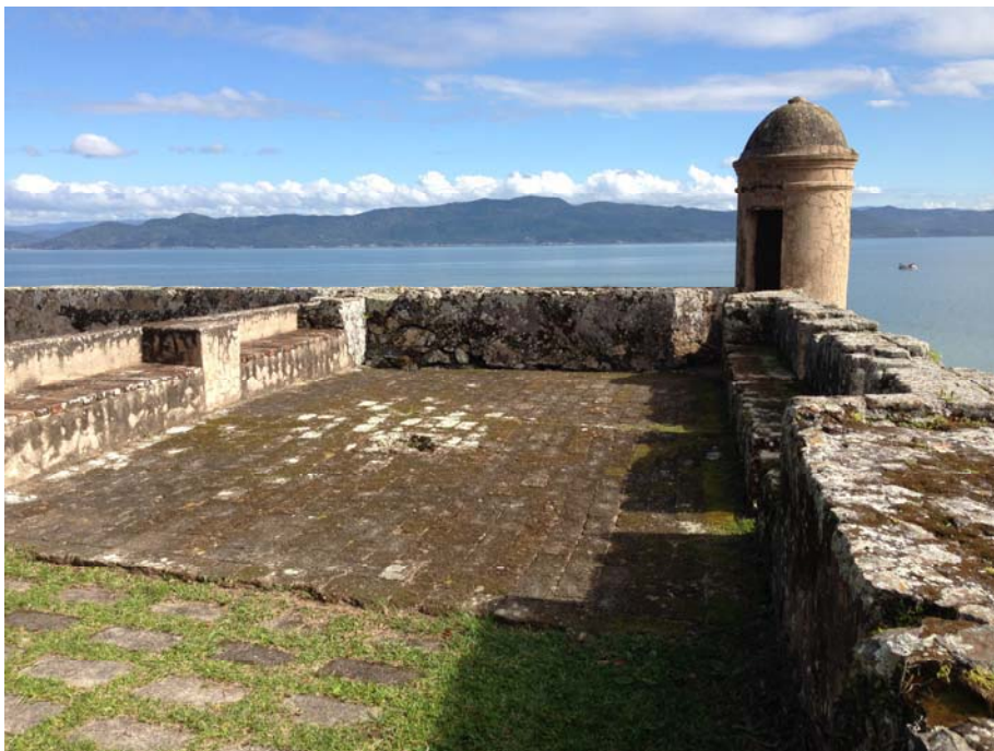
Figura 333 - Terrapleno sobre o trânsito. Ao centro estrutura vasada que atravessa a abóbada sobre o trânsito.
