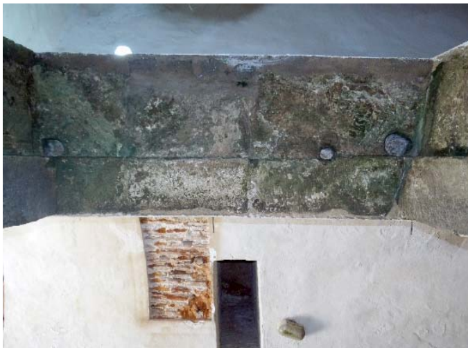
Figura 361 - Marca de assentamento do sistema pivotante e do ferrolho.
