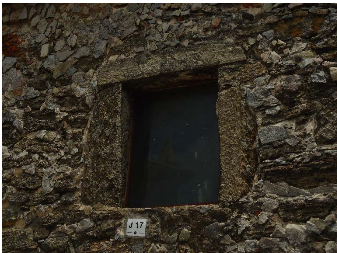
Figura 137 - Panorâmica da Janela 17 com ombreiras e verga em arenito.
