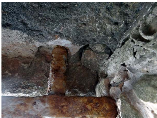
Figura 79 - Marca de eixo na verga.
