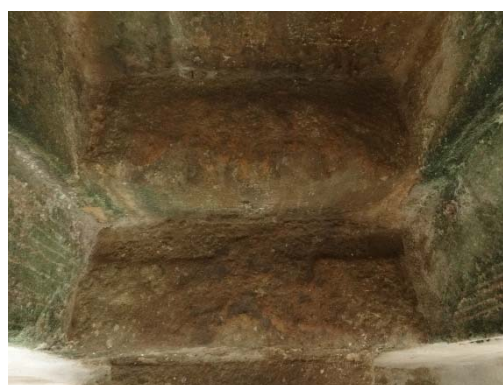
Figura 283 – Desgaste na soleira.
