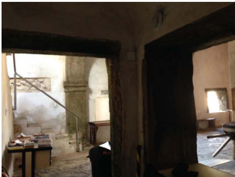
Figura 364 - Vista do interior do cômodo, vendo-se as duas portas.
