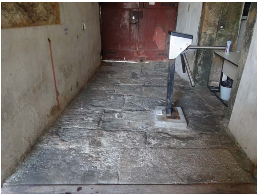
Figura 357 - Panorâmica do piso de trânsito.
