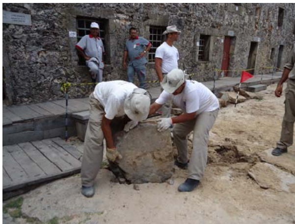
Figura 48 – Remoção do piso atual da Praça de Armas.
