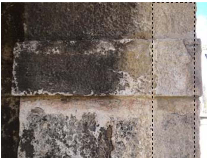
Figura 394 - Marca da parede na coluna do arco leste (realce do contorno).
