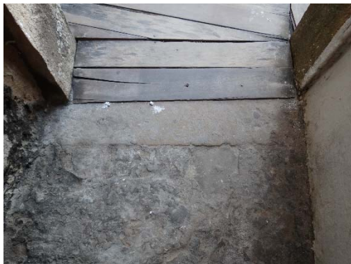
Figura 255 - A soleira foi substituída.
