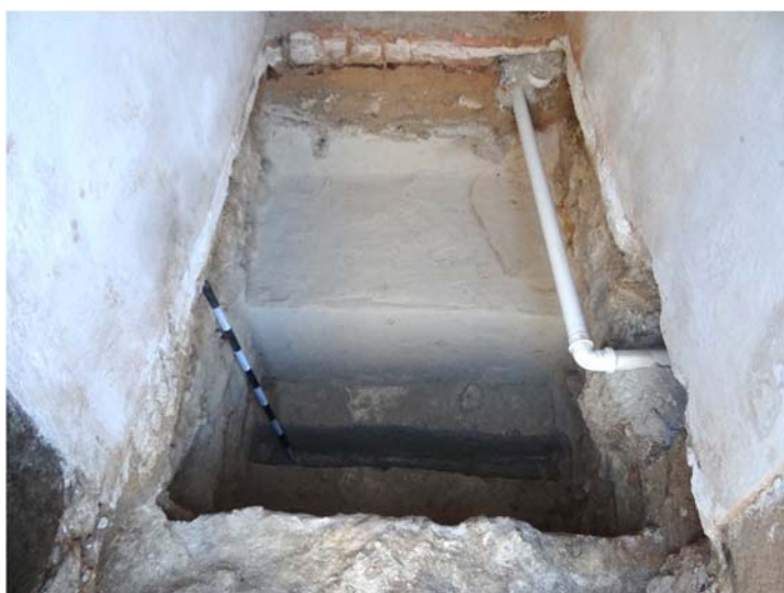
Figura 8 - Aterro de areia branca desde o arrecife até o contapiso do 1º piso de tijoleira quadrada.
