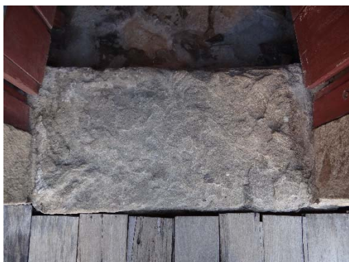
Figura 266 - Soleira formada por uma única pedra em cantaria.
