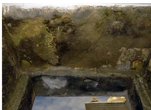
Figura 110 - Na veja há marcas de eixo.
