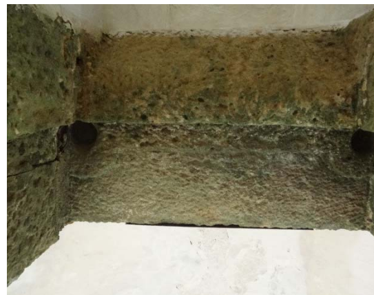
Figura 427 - Verga vista por baixo, onde se pode observar de ambos os lados as marcas de encaixe da peça pivotante.
