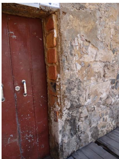
Figura 257 - A ombreira esquerda foi parcialmente reconstruída em tijolo sobre arenito
