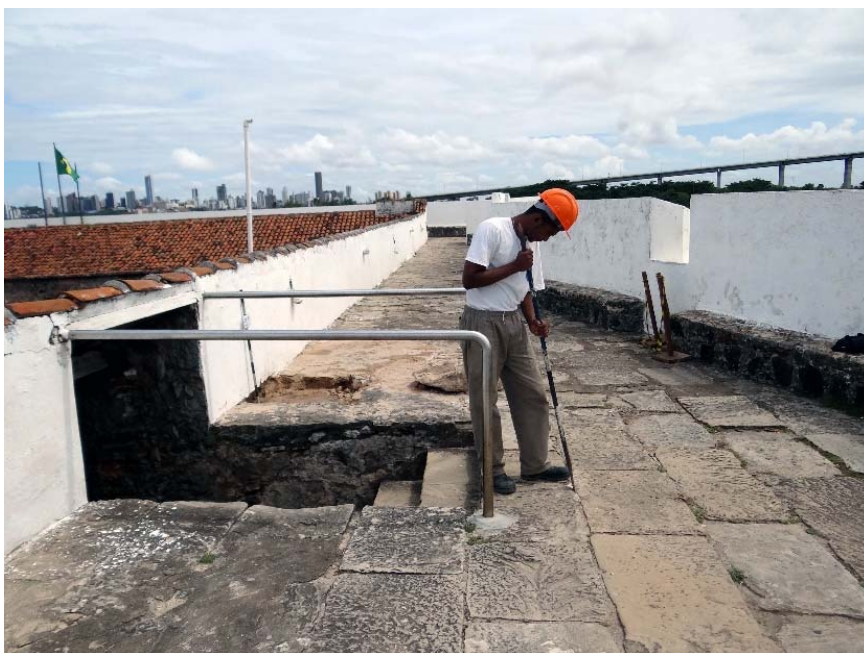
Figura 486 – Escada de acesso ao terrapleno na face oeste que avança sobre o terrapleno.
