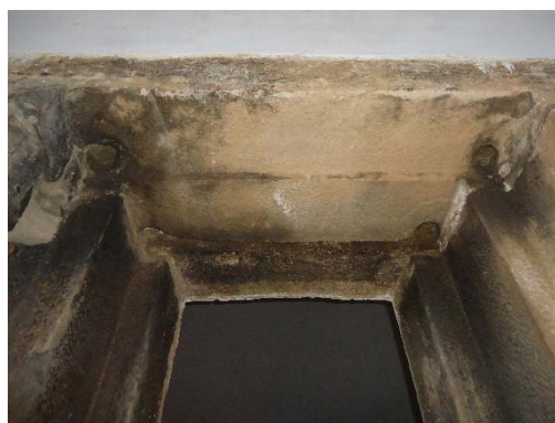
Figura 234 - Verga mostrando os encaixes das duas portas, ambas de folha dupla.
