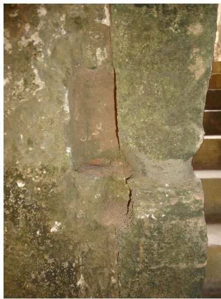
Figura 300 – Marca de encaixe na ombreira.
