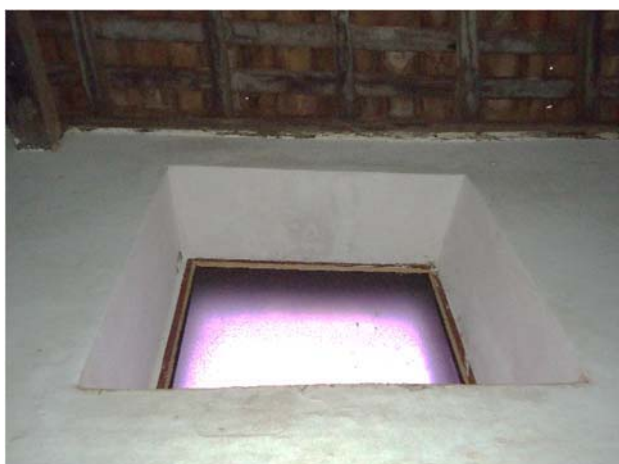
Figura 157 - Marca de eixo fechada com cimento.
