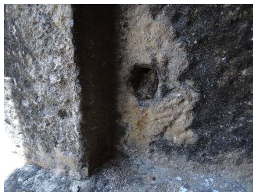
Figura 227 – Encaixe para ferrolho.
