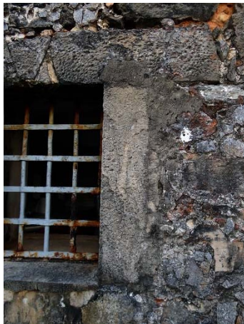
Figura 95 - A ombreira esquerda foi substituída.
