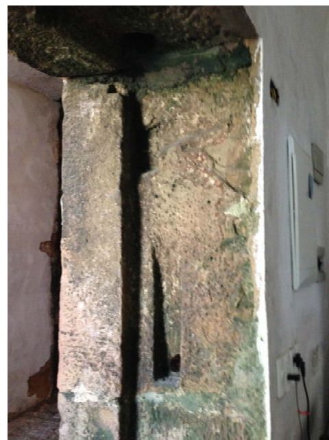
Figura 362 - Marcas de encaixe das tramelas.
