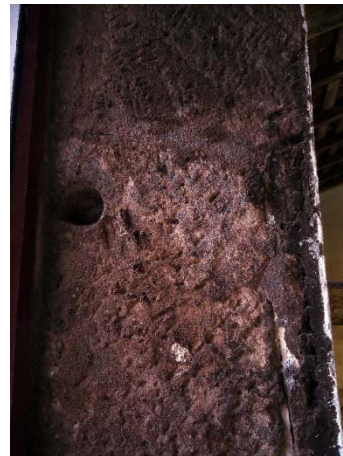
Figura 144 - Marca de tramela na ombreira esquerda. Figura 145 - Marca de tramela na ombreira direita.
