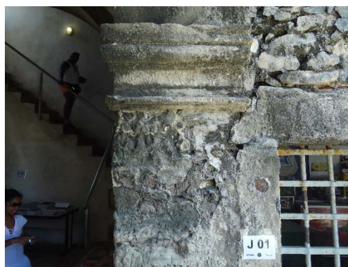
Figura 200 - Conserto em cimento.
