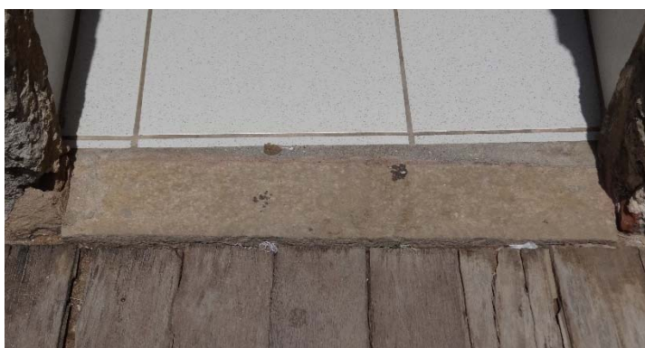
Figura 220 - Soleira substituída.
