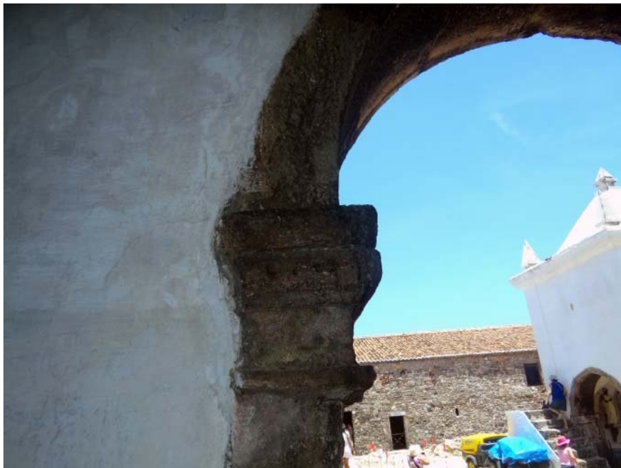
Figura 343 - Detalhe da base de um dos arcos em sua feição original. Observe-se que em parte é "engolido" pela parede.
