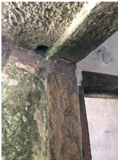
Figura 367 - Detalhe da marca de encaixe da porta (pivô) e do 'batedor'.
