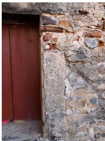
Figura 114 - A verga foi substituída por concreto.
