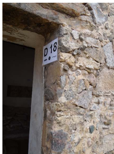
Figura 242 - Ombreiras em parte substituídas por granito e tijolo vermelho
