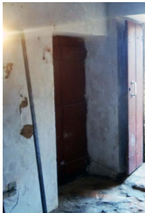
Figura 286 - O vão da porta entre os cômodos 21 e 22 está rebocado.
