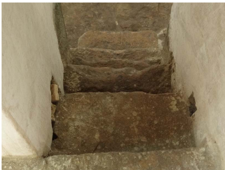
Figura 430 - Conjunto de degraus da escada, vistos do alto.
