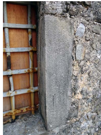
Figura 85 - A ombreira esquerda foi substituída.
