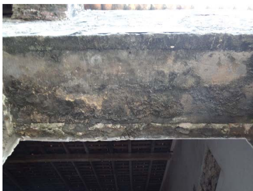
Figura 222 - A verga foi substituída por concreto.
