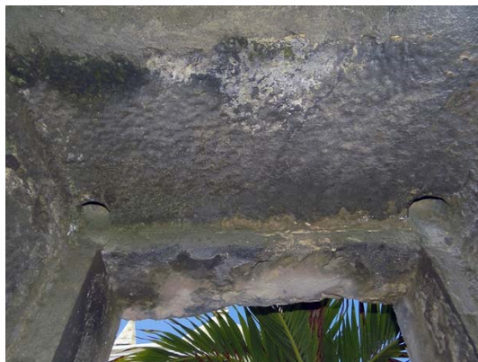
Figura 105 - A verga possui marcas de eixo.
