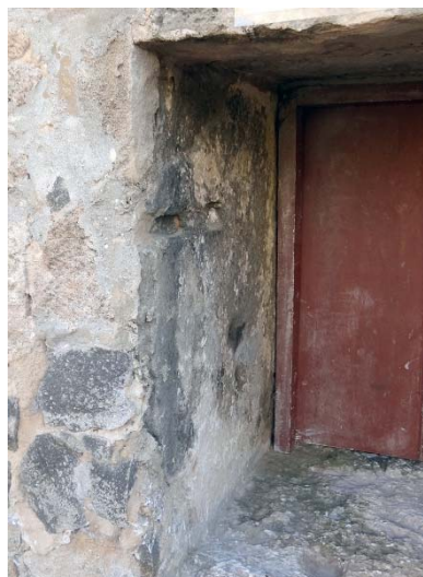
Figura 119 - Marca de canaleta na ombreira esquerda. Pode ser de prateleira. A posição da marca, voltada para fora, indica que esta peça foi recolocada.
