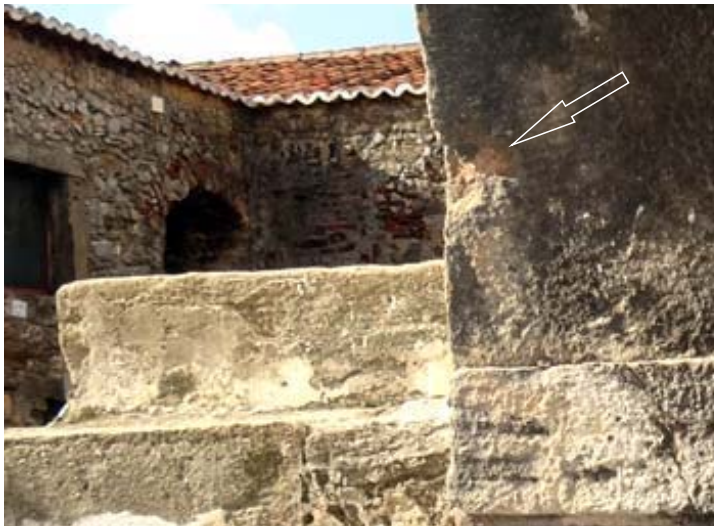
Figura 397 - Marca de encaixe, parcialmente fechado com argamassa, no arco oeste.
