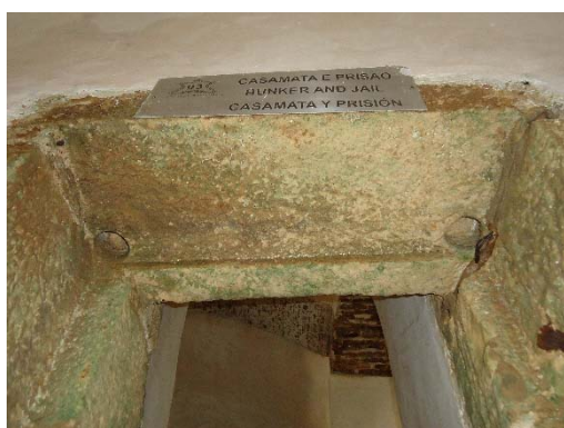
Figura 282 – Marca de eixo na verga de arenito.
