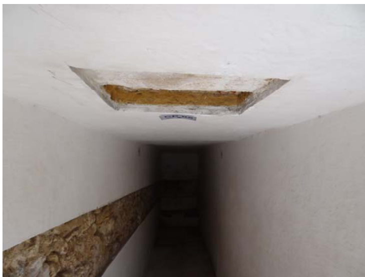
Figura 418 - Corte longitudinal ao longo de toda a parede da poterna, em busca de possíveis sinais de alteração.
