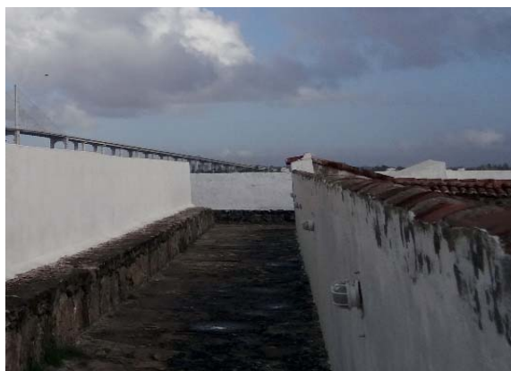
Figura 332 — O lajeado do terrapleno não mostra a estrutura do Traidor.
