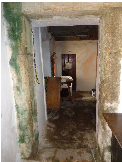
Figura 290 - Panorâmica da Porta entre as dependências 22 e 23.
