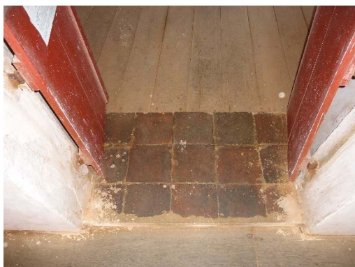
Figura 313 - Soleira em cerâmica
