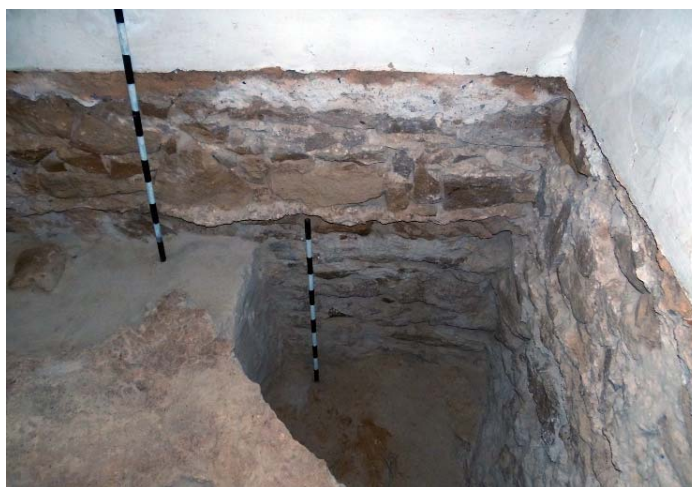
Figura 442 – Esborro de argamassa indicando nível de piso.
