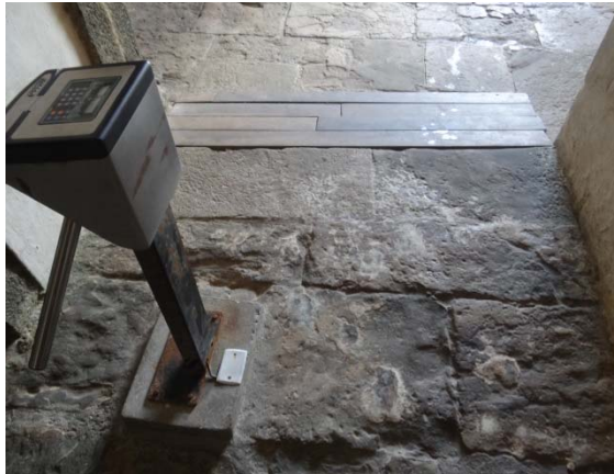
Figura 345 - Detalhe do piso, no trecho em que cobre a marca de remoção da parede.
