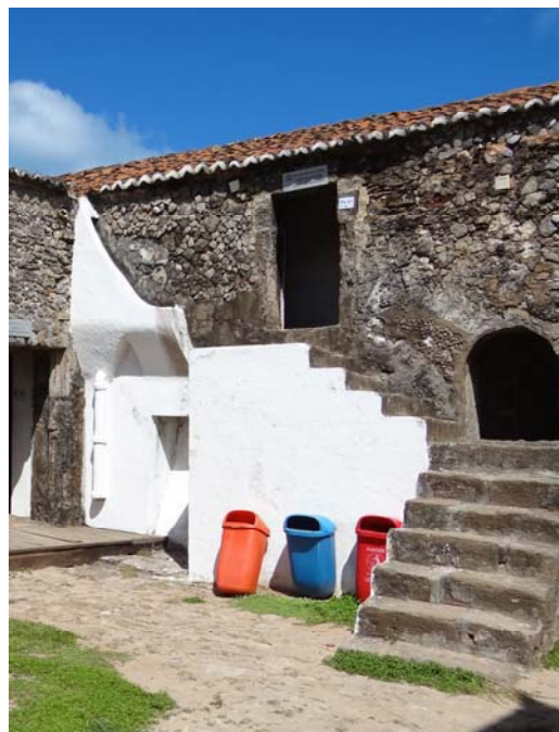
Figura 407 - Acesso à cister na na D16 em dois lances de escada.
