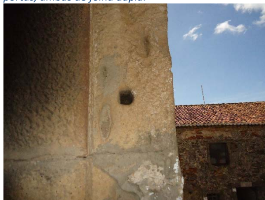
Figura 236 - Marca de ferrolho.
