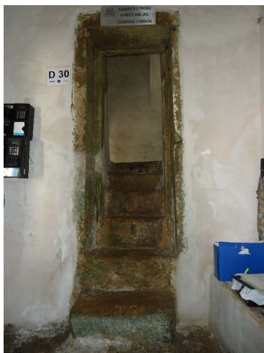
Figura 281 – Pa norâmica da Porta 30. Escada que leva à casamata oeste.
