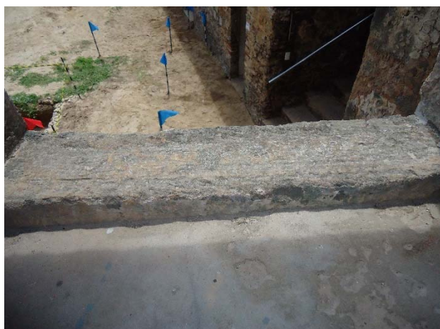
Figura 163 - Marca de tramela na ombreira esquerda e rachadura acentuada.
