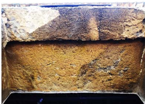
Figura 245 – Verga substituída por concreto.
