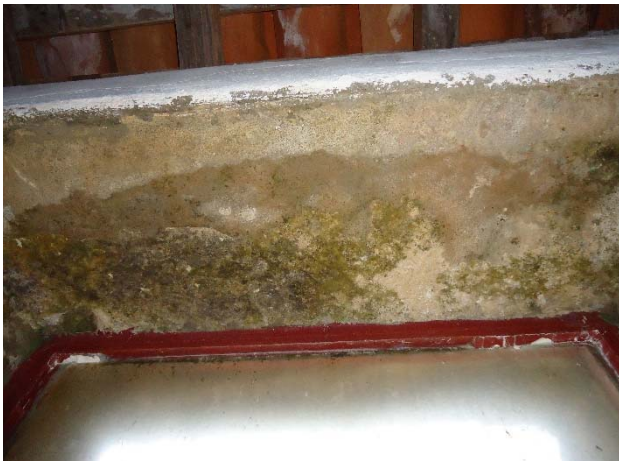
Figura 133 - Verga consertada com cimento.
