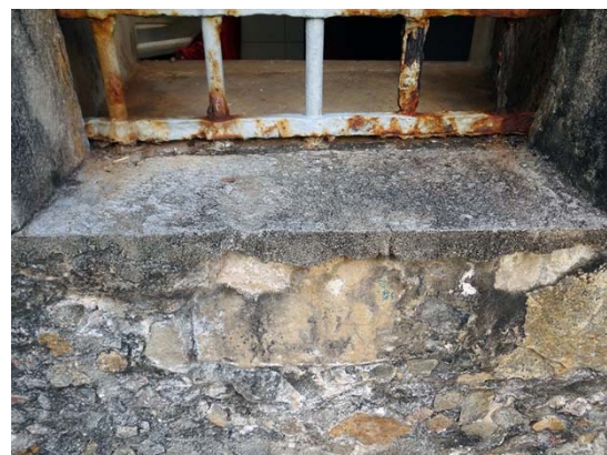
Figura 96 - O peitoril foi reconstruído.
