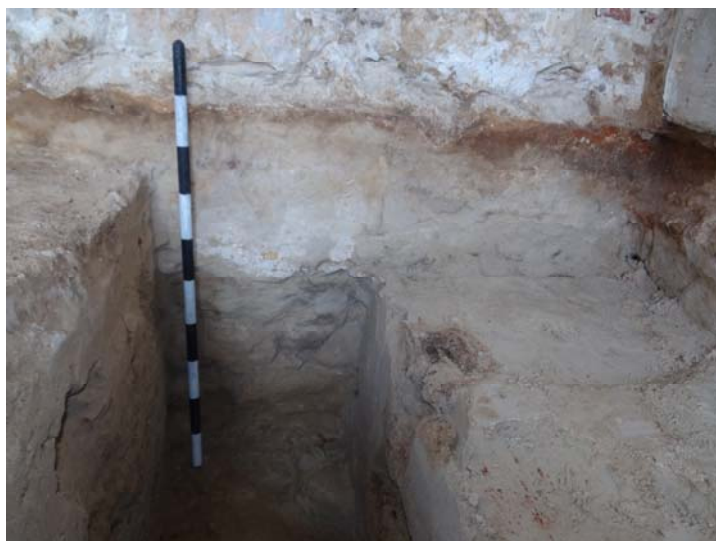
Figura 21 - Vestígio de reboco e argamassa que indicam o nível de um antigo piso, descobertos no corte CH 65.
