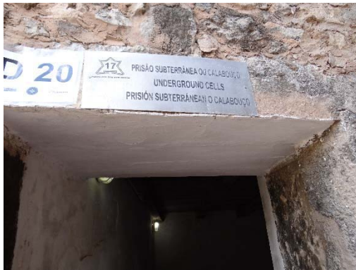
Figura 253 - A verga está reconstruída em concreto
