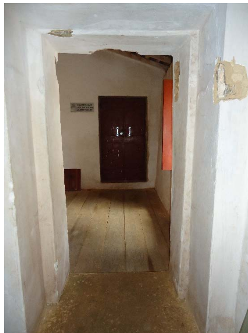
Figura 308 - Panorâmica da porta entre os cômodos 121 e 122, acima de onde hoje estão os banheiros
