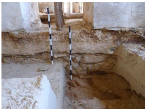
Figura 22 - Reboco indicando nível de antigo piso no corte CH 66. Observe-se camada de aterro de areia branca apartir dos arrecifes.
