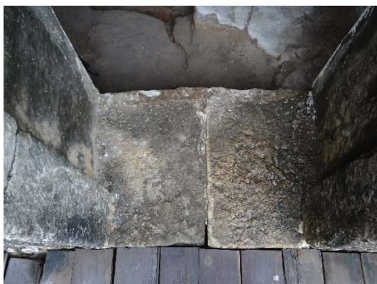
Figura 228 – Soleira formada por duas peças em cantaria.
