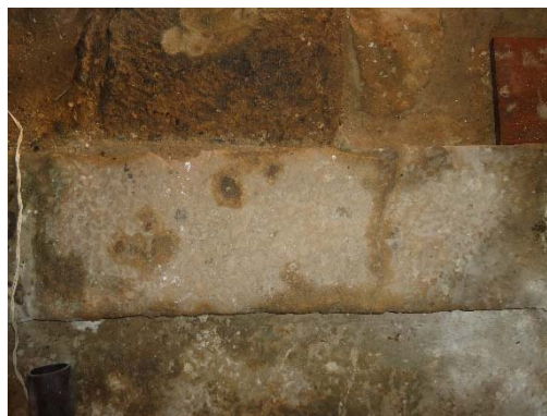
Figura 292 - Soleira sem marcas de portas.
